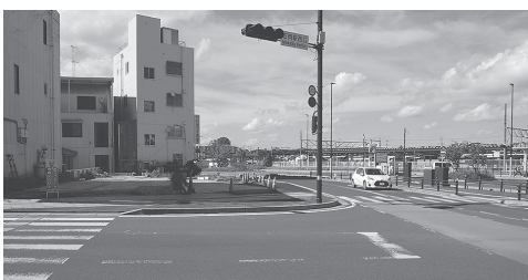
▲徐々に工事が進む石岡駅西口の道路
