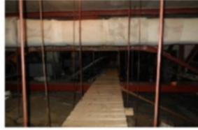
〔3階ホール裏側〕吊りボルト抜け止めなし
