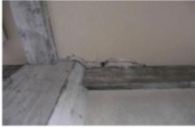
〔1階ホワイエ〕天井部分にクラック・鉄筋が露出・発錆
