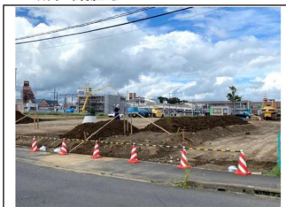
石岡一高側から
