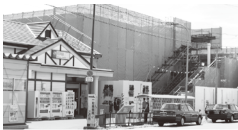
▲夏の一部供用開始に向け工事が進む石岡駅舎
