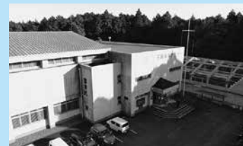
▲石岡海洋センター
