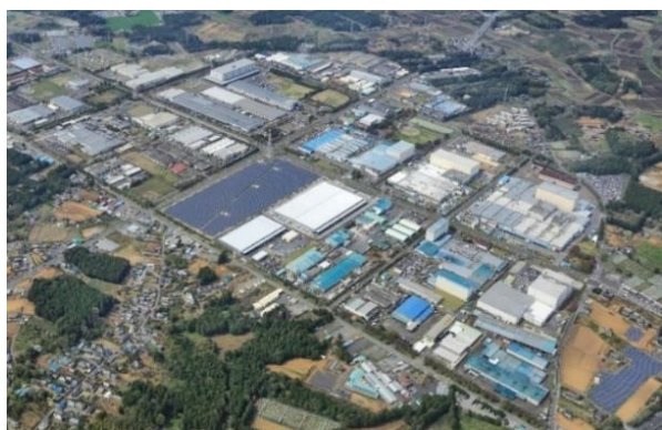
【柏原工業団地の上空からの写真】
